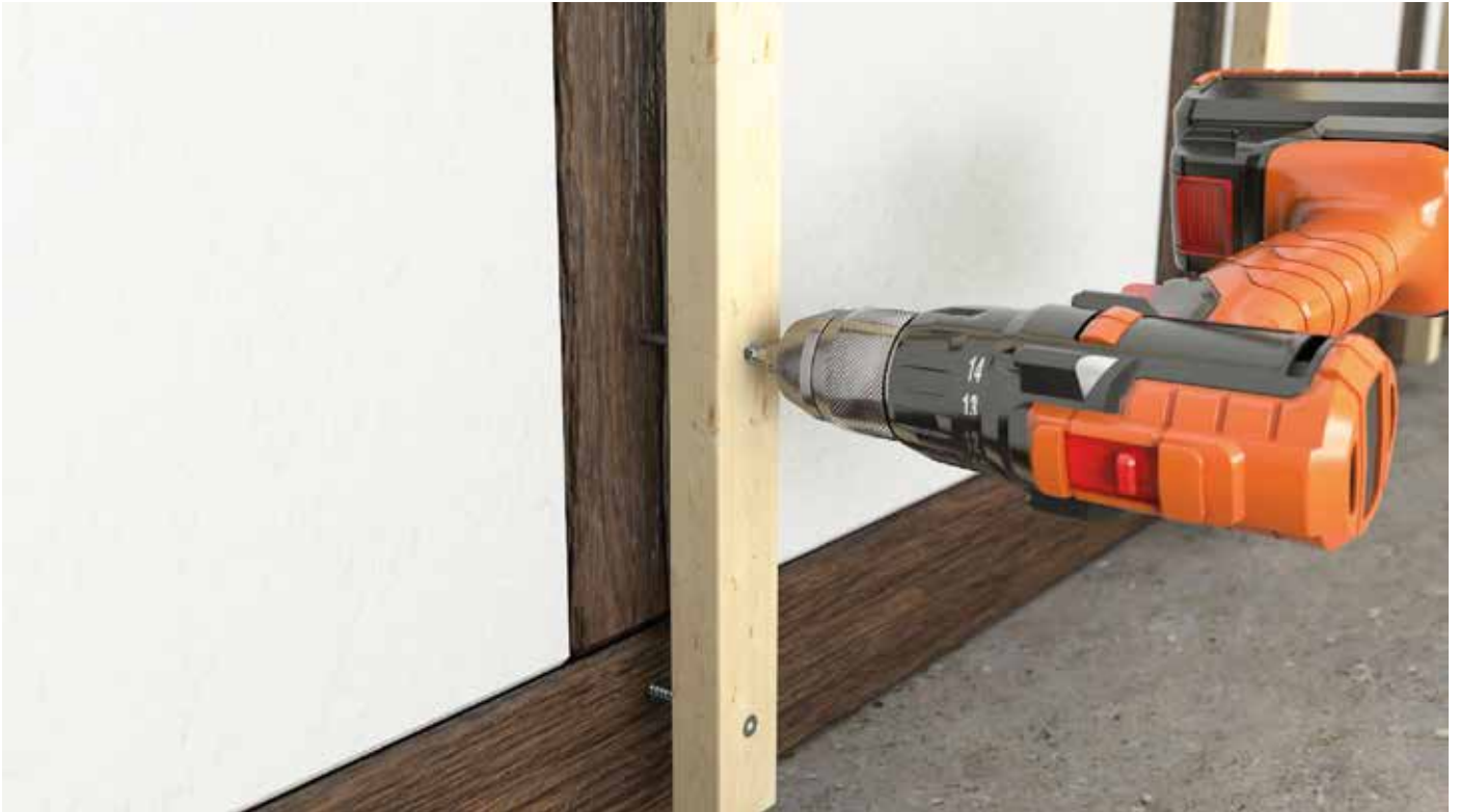
Schnelles Ausrichten einer Unterkonstruktion mit der Justitec.
